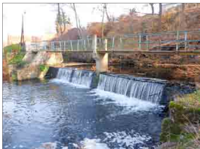
Ansicht auf das Wehr Sportplatz von unterstrom (Foto: ThLG)
